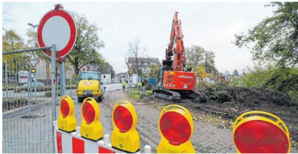
Sperrung eingerichtet: An der Stummrigestraße nahe der B64 wird gebaut.
